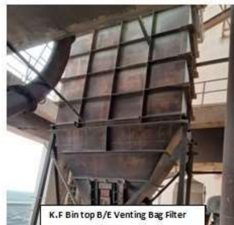
K.F.B/E P.H venting Bag Filter
